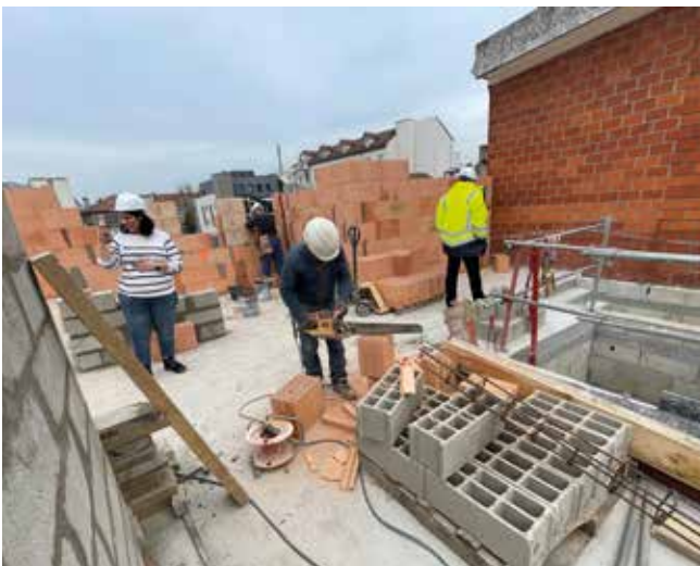
Les maçonneries sont érigées en brique porotherm. Les alvéoles de la brique constituent un vide d'air et donc une isolation thermique naturelle et pérenne.
