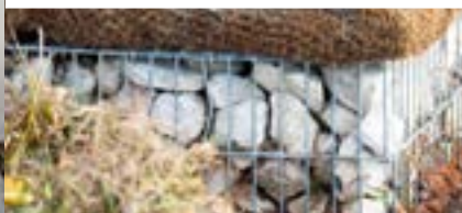
Des gabions et roches pour consolider les berges
